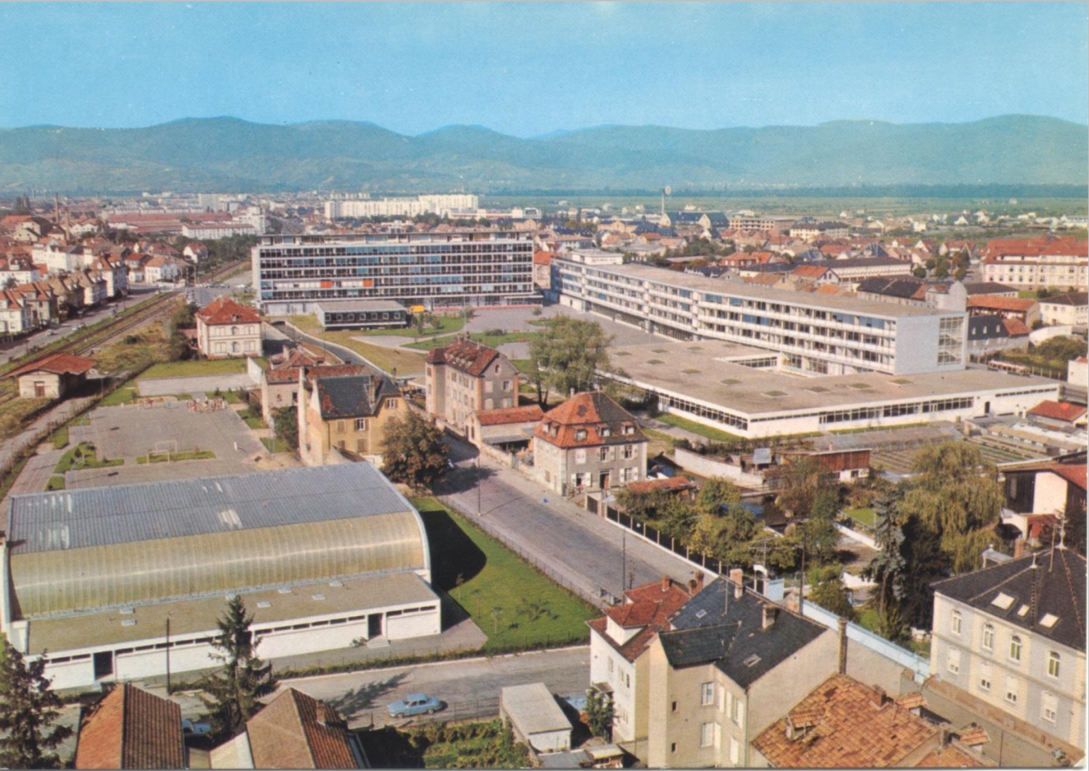
Des photos des bâtiments 1964
