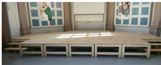
Réalisation d'une estrade pour une salle de spectacle
